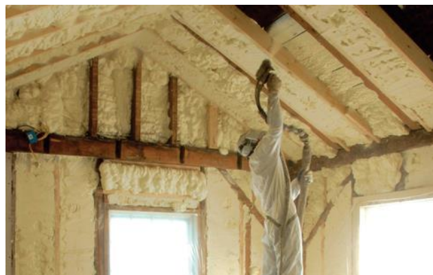
Projetado ou injetado in situ
